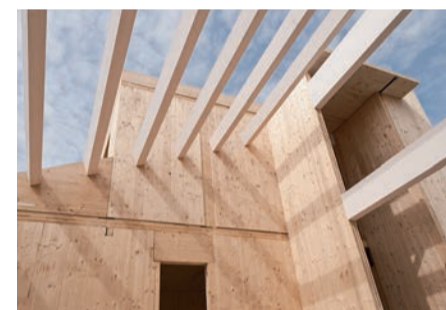
Costruzione casa in legno con pannelli X-Lam
